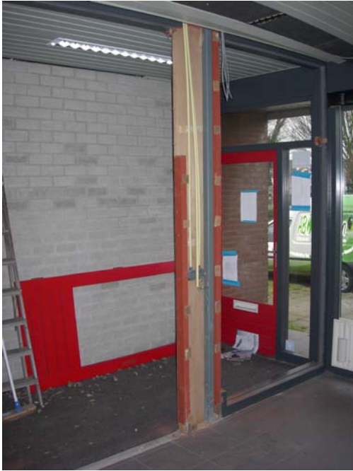
Slopen bij Cito in Axel
